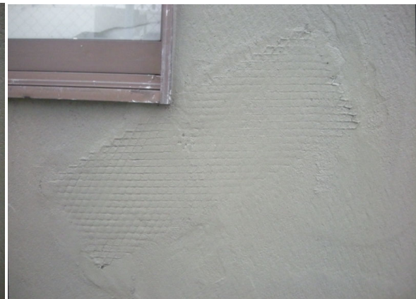
補強用ラスの伏せ込み後
