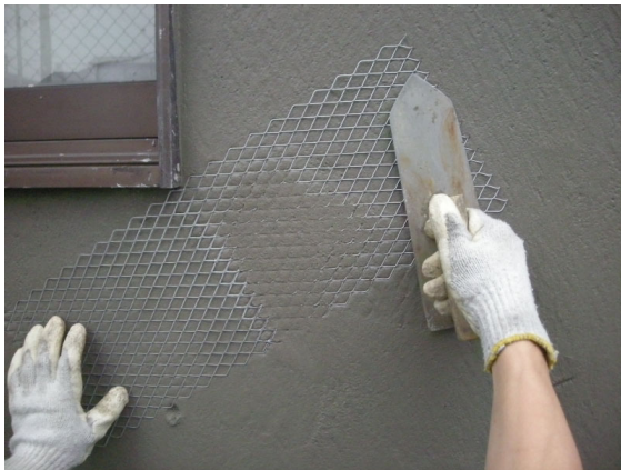
補強用ラスの伏せ込み
